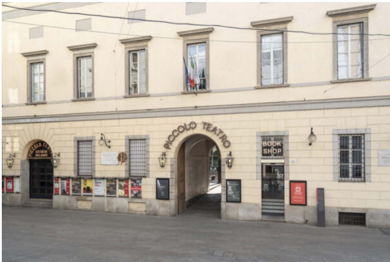
Exterior, Sala Grassi. Photo: Masiar Pasquali. Courtesy of the Press Office of the Piccolo Teatro di Milano.
